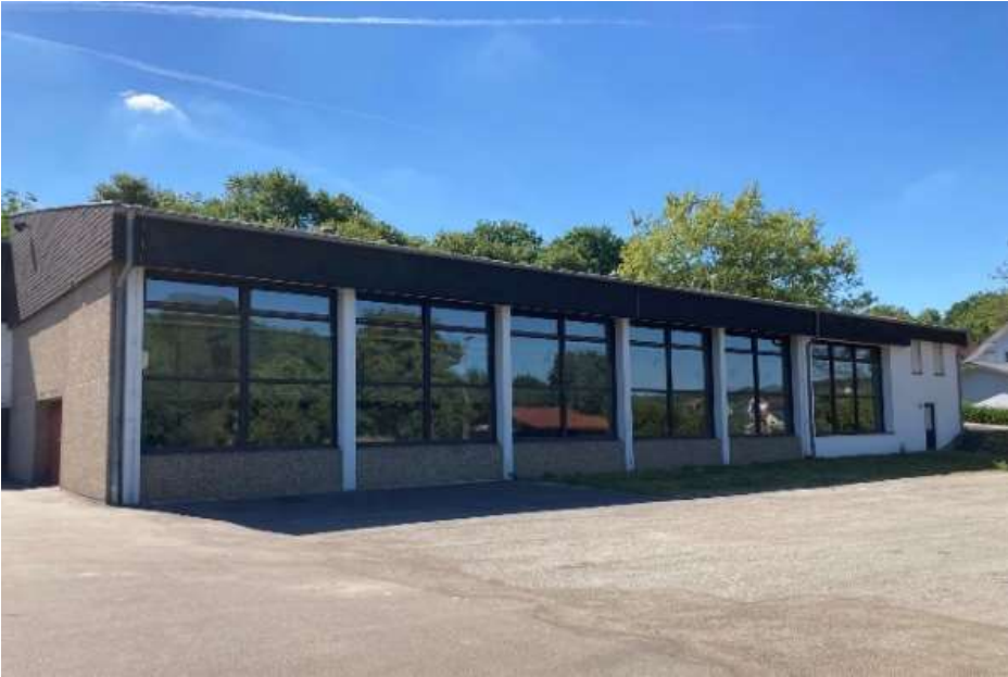
Ostseite (Große Glasflächen der Sporthalle) und davor die asphaltierten Hofflächen
