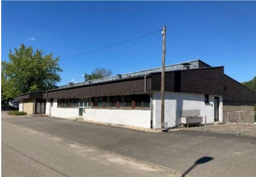
Westseite mit Zufahrtsstraße „Alte Steige“ und Hauptzugang im OG
